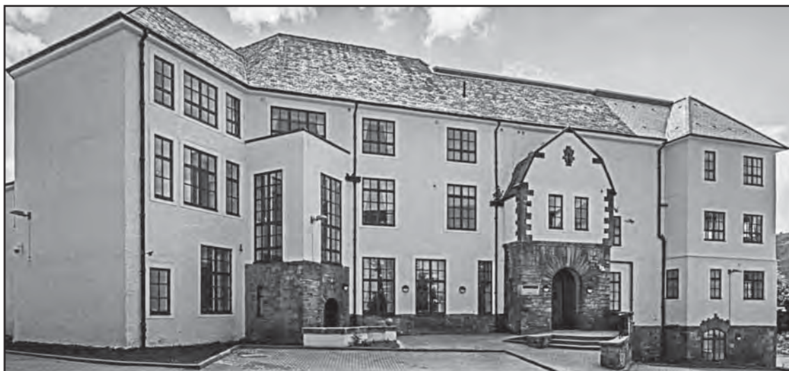
Die heutige Frontansicht des ehemaligen Elsie Inglis Memorial Maternity Hospital in Edinburgh, Schottland.
